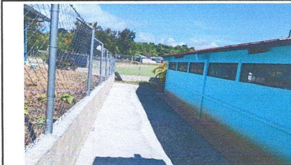
Foto 2: Nivelación de terreno en pared de aulas.
