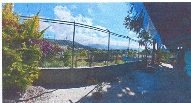
Foto 3: Muro perimetral e instalación de tubo para base de maya.
