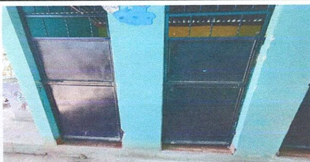
Foto 5: Instalación de azulejo y rejas en puertas de sanitario.
